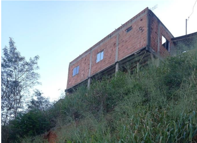
Figura 3 – Área 1: Edificação construída às margens da encosta.
