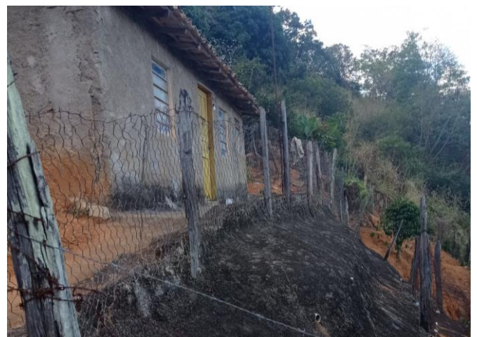
Figura 6 – Área 2: Casa localizada à montante da encosta.
