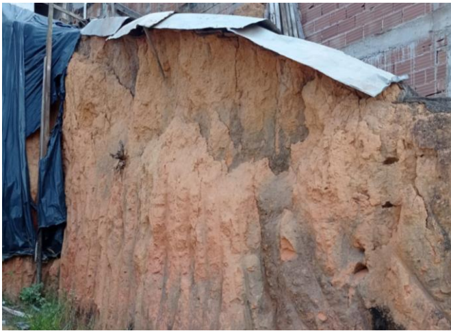
Figura 11 – Área 4: Lateral com indícios de erosão.
