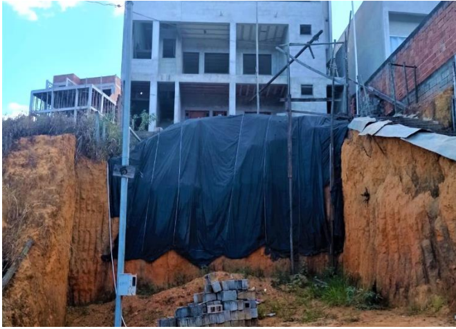
Figura 10 – Área 4: Construção próxima a um talude artificial.
