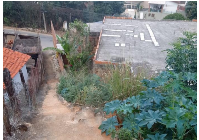
Figura 5 – Área 1: Casa localizada à jusante do terreno.
