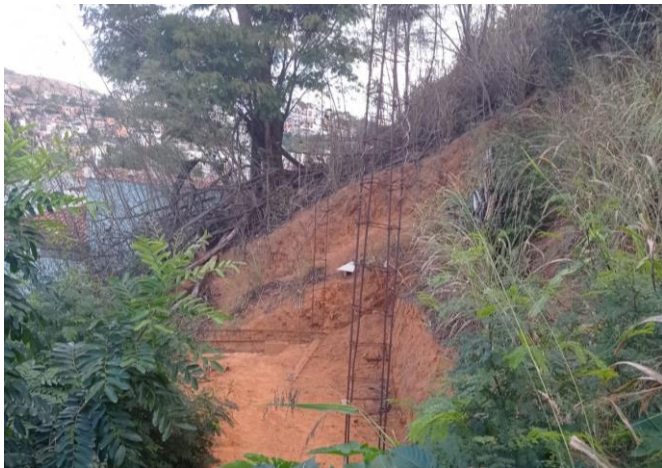
Figura 4 – Área 1: Terreno à jusante da casa construída na encosta.
