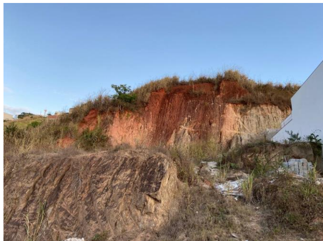
Figura 5 – Talude com indícios de instabilidade.
