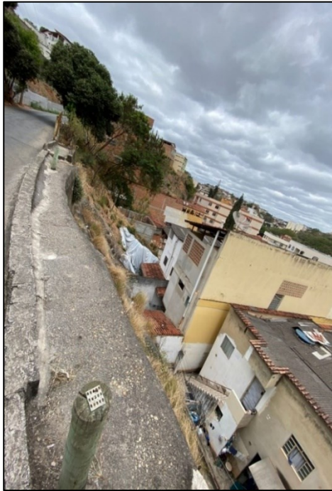
Figura 4 – Vista superior do talude em corte na Rua Riccioti Míglío (Ponto 1).
