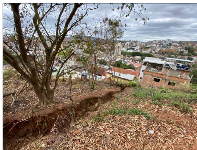
Figura 9 – Ravina no topo do talude situado na Rua Minervino de Castro Pinto (Ponto 3).
