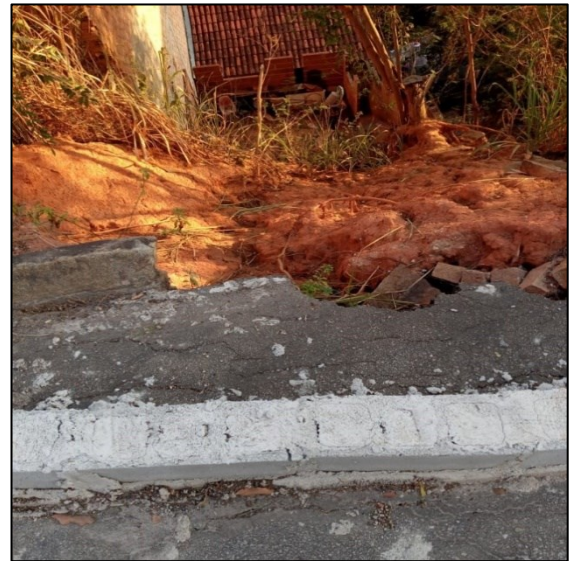
Figura 6 – Talude em corte na Rua Riccioti Míglío (Ponto 2).
