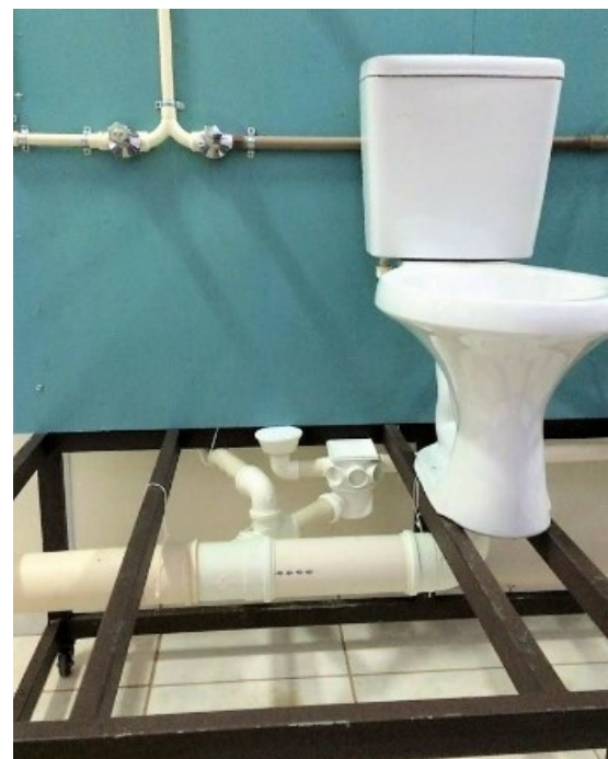
Figura 5 – Fixação das tubulações de esgoto cloacal.
