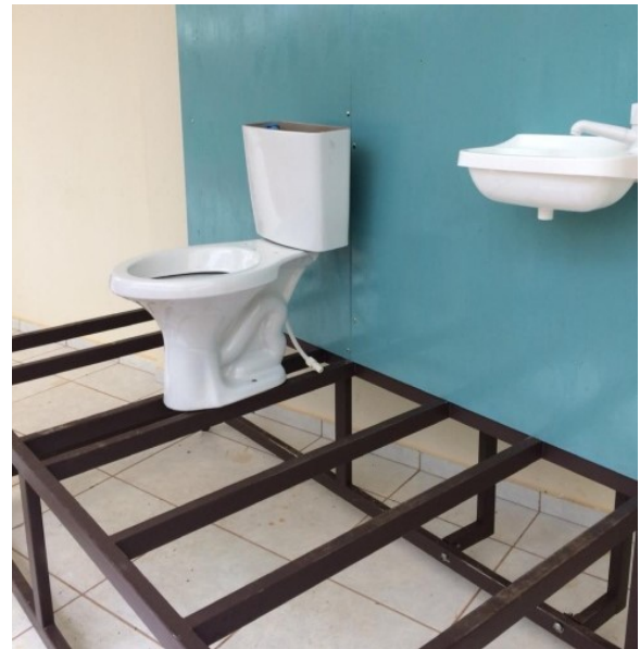
Figura 3 – Posicionamento dos aparelhos sanitários.
