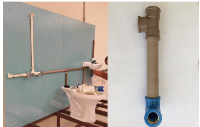
Figura 4 – À esquerda montagem da instalação da tubulação de água fria e água quente. À direita sub-ramal joelho rosca bucha de latão.
