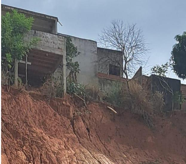
Figura 11 – Lançamento de águas servidas no talude.
