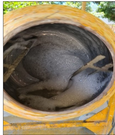
Figura 3 – Mistura do aditivo incorporador de ar e água.
