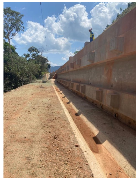
Figura 16 – Muro de contenção concluído, Pará, Brasil. 2020.
