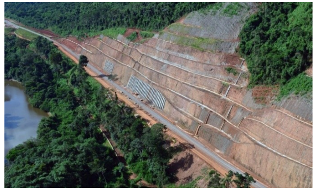
Figura 2 – Foto panorâmica do local de estudo detalhando o talude de aterro instável. Pará, Brasil. 2020.
