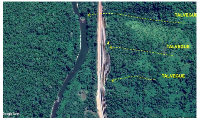
Figura 3 – Canais de drenagem superficiais. Pará, Brasil. 2020.
