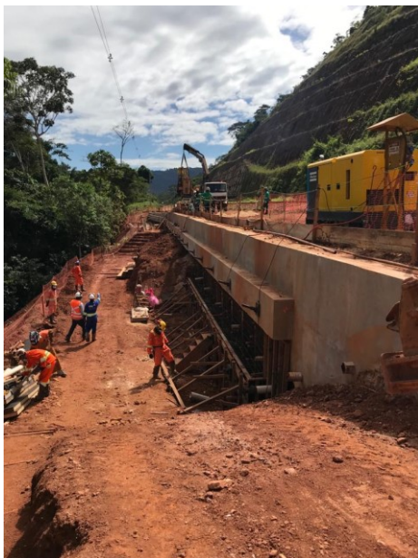
Figura 15 – Atividades de execução do muro de contenção. Pará, Brasil. 2020.
