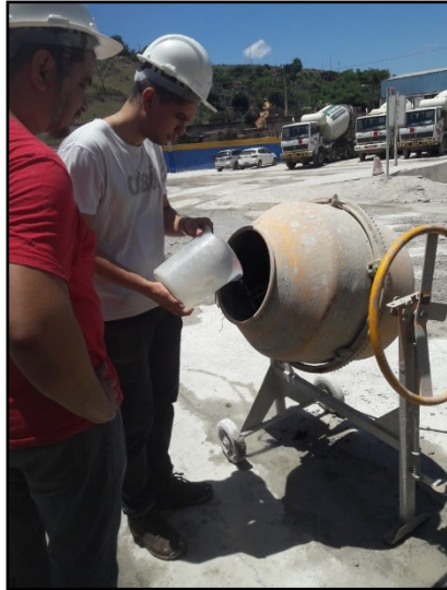
Figura 6 – Mistura mecânica dos materiais constituintes das misturas dos concretos.
