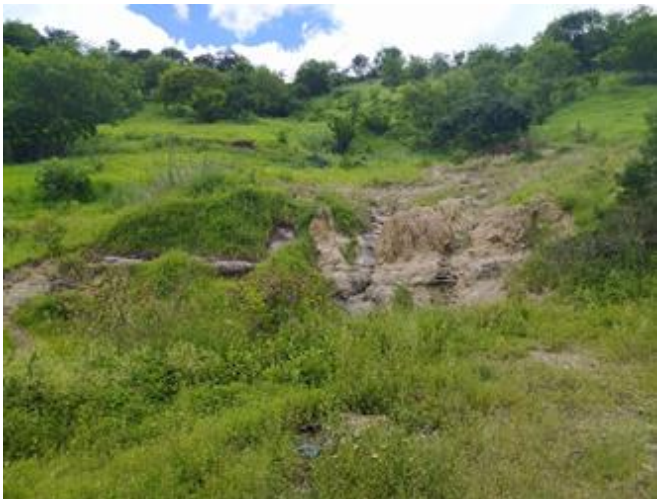
Figura 36 – Ponto 06: Trincas e ravinas.
