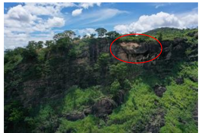
Figura 8 – Ponto 02: Nota-se evidências de mobilização de blocos rochosos no passado.
