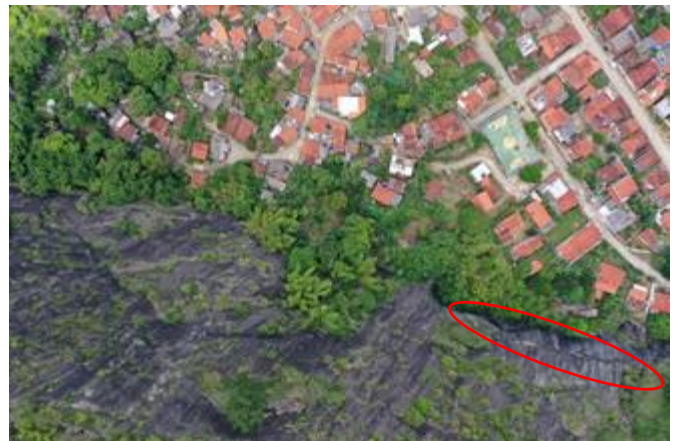
Figura 4 – Ponto 01: Vista do alto da encosta e moradias sujeitas a queda de blocos no bairro Pedreira.
