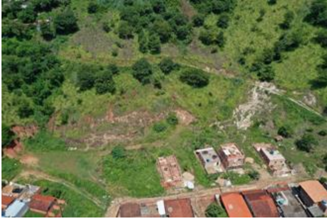
Figura 14 - Ponto 06: trincas e ravinas na Estrada. Coordenadas geográficas: 41°41'22,3"W e 18°2'26,0"S.
