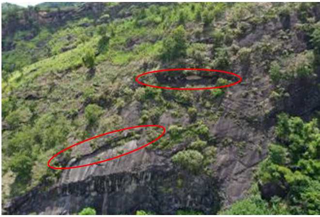
Figura 5 - Ponto 01: Evidências de mobilização de blocos no local.
