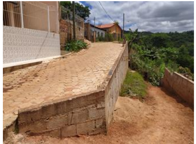
Figura 12 – Ponto 04: Sistema de estabilização do solo.
