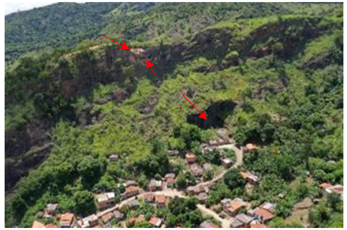
Figura 7 – Ponto 02: Visão geral da morfologia da encosta e residências em risco no bairro Santa Clara. Coordenadas geográficas: 41°40'34,0"W e 18°1'38,7"S.
