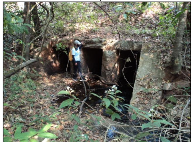
Figura 7 – Travessia do tipo bueiro celular triplo em alvenaria de pedra seca.
