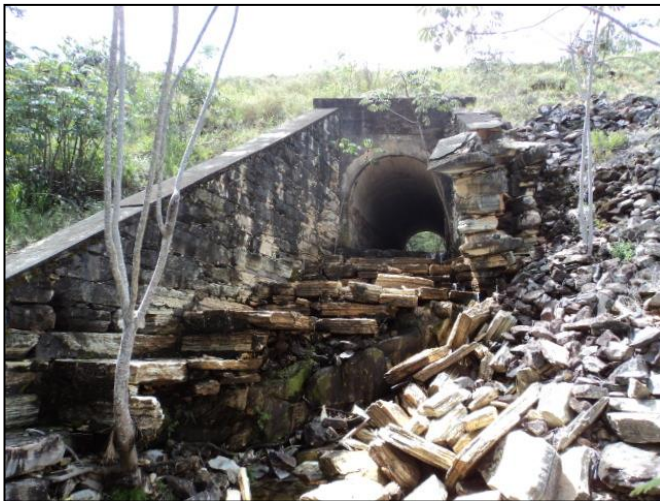
Figura 18 – Boca jusante e escada dissipadora de energia do bueiro ogival próximo ao distrito de Conselheiro Mata.
