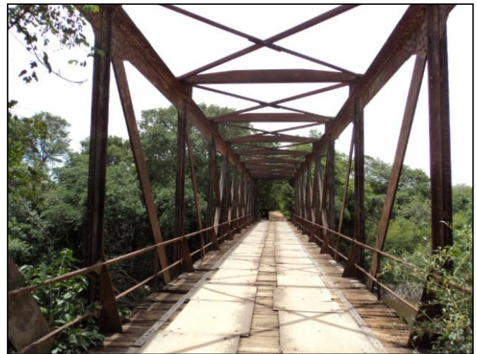
Figura 8 – Travessia do tipo ponte metálica treliçada sobre o Rio Pardo Pequeno no município de Monjolos.
