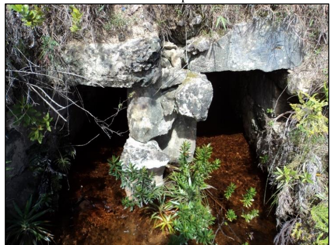
Figura 6 – Travessia do tipo bueiro celular duplo em alvenaria de pedra seca.
