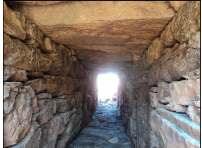
Figura 5 – Travessia do tipo bueiro de greide celular simples em alvenaria de pedra seca.
