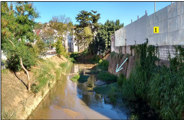
Figura 16A - Setores 13 e 14 – Ponte próximo à estação rodoviária (2016).
