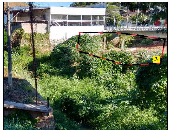
Figura 14B – Setor 09 – Ponte BR 116 (2016).
