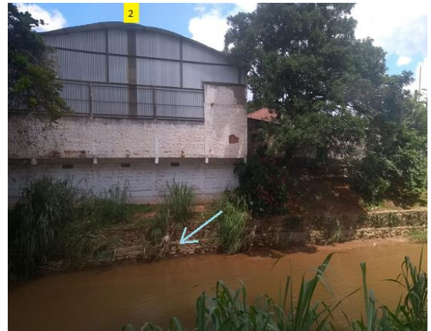
Figura 17B – Setores 13 e 14 - Ponte próximo à estação rodoviária.
