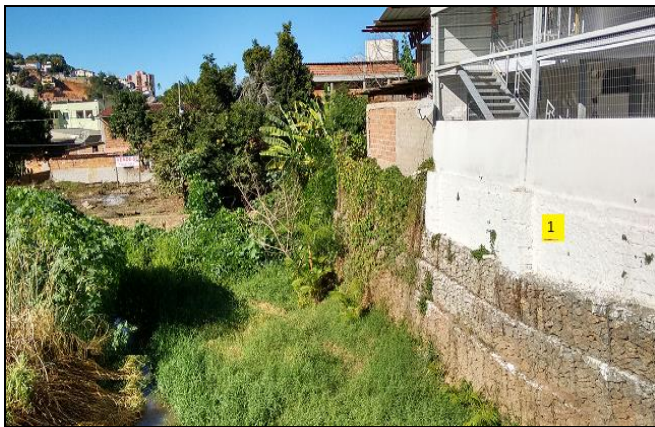
Figura 14A – Setor 09 – Ponte BR 116 (2016).
