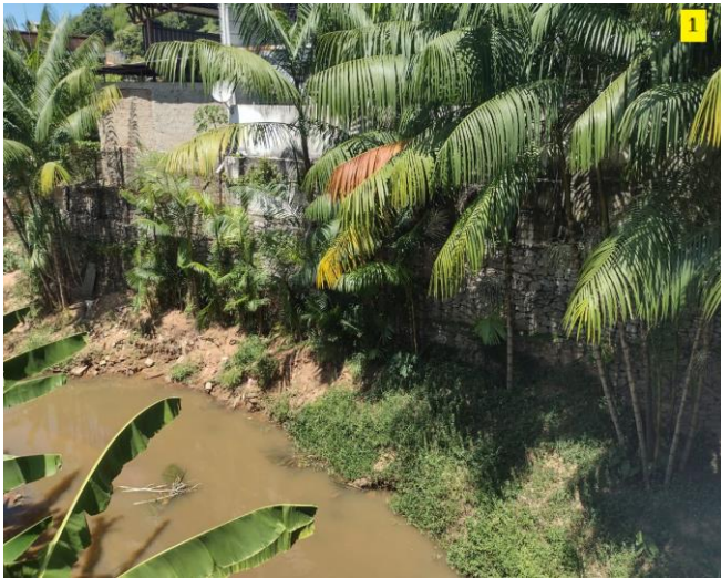
Figura 15A – Setor 09 – Ponte BR 116 (2021).
