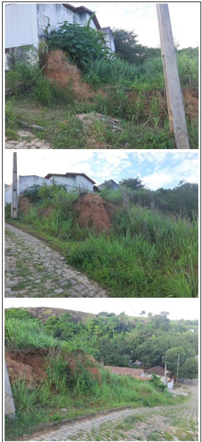
Figura 7 – Imóvel localizado sob talude em processo erosivo.
