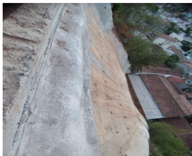
Figura 4 – Talude Argamassado.
