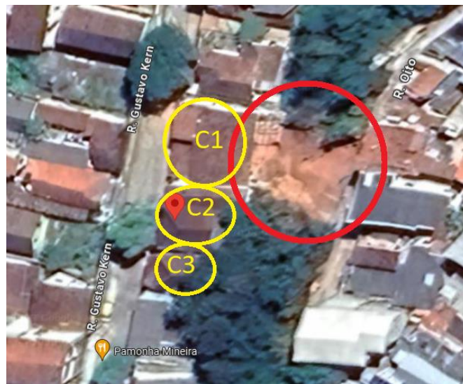
Figura 3 – Deslizamento de maciço de solo no Bairro Manoel Pimenta, Entre Rua Oito e Rua Gustavo Kern.
