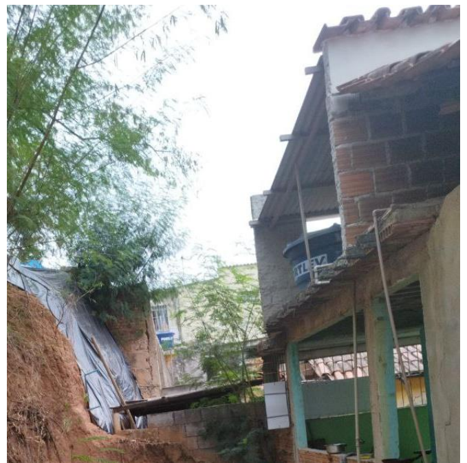
Figura 7 - Talude com Lona preta
