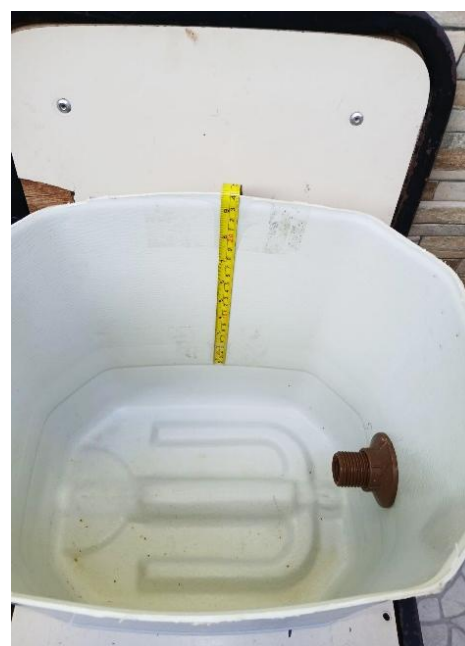
Figura 3 – Detalhe da fita métrica posicionada no interior do reservatório.
