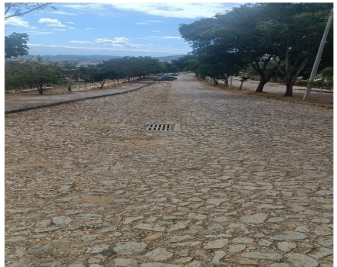
Figura 23 – Boca de lobo no meio da via.
