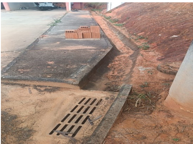
Figura 26 – Canaleta obstruída.
