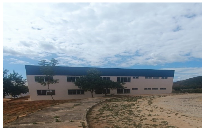
Figura 17 – Laboratório das engenharias.
