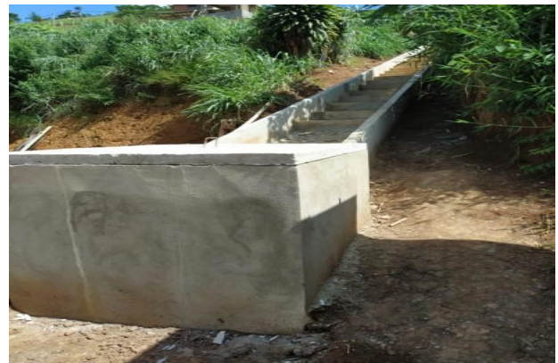
Figura 10 - Exemplo de escadaria de drenagem.
