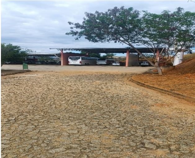
Figura 25 – Prédio do transporte.
