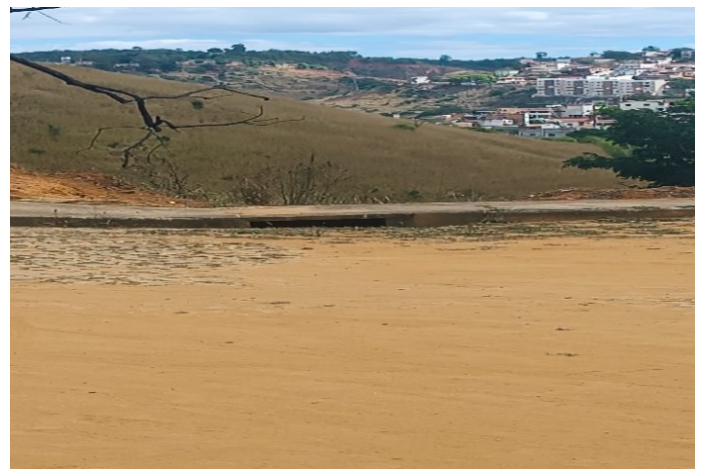
Figura 8 – Boca de lobo em local inadequado.
