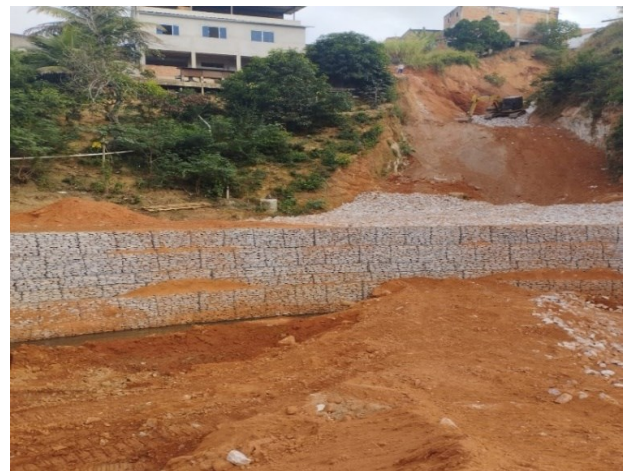
Figura 11 – Exemplo do muro de gabião.
