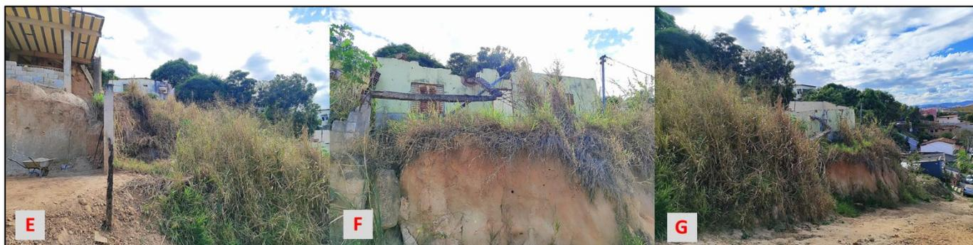
Figura 6 – Os pontos E, F e G apresentam as fissuras no solo e paredes de edificações inclinadas com rachaduras, evidenciando sinais de movimentos de rastejo na área estudada.
