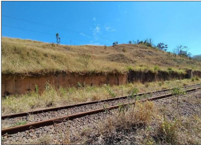
Figura 4 – Cortina atirantada em estudo (Rincent BTP, 2024).
