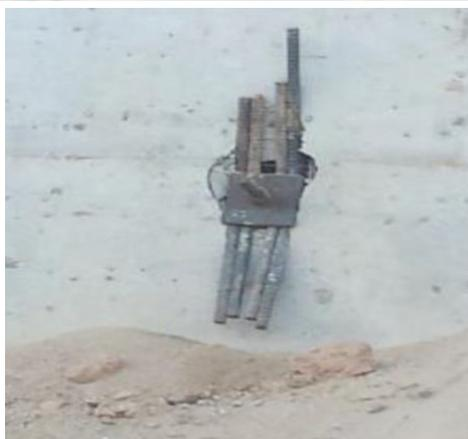
Figura 3 - Colapso estrutural de cortina atirantada (Porto, 2017).
