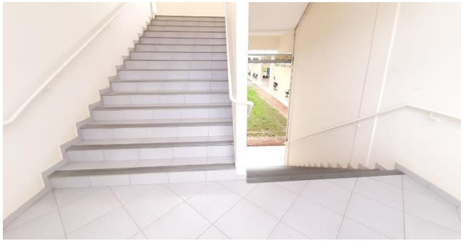
a) Escada Não Enclausurada
