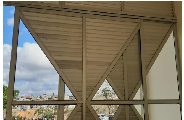
Figura 12 – Porta de Saída de Emergência.
